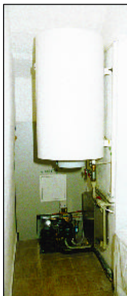
Kondenzační jednotka se zásobníkem a výměníkem teplé vody s možností elektrického ohřevu
